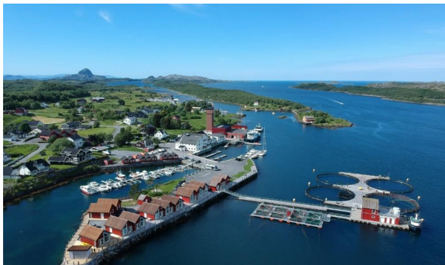
Figur 10 Dronefoto av Toft sett fra nord. I vest (t.h.) ligger øya Sauren, og videre mot øst Toftsundet og Toftøya. Bakerst ligger Torget og Torghatten (t.v.). Kilde: Toft Brygge
