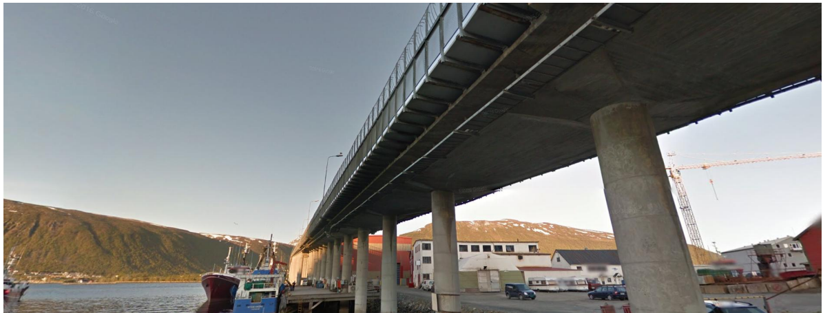
Figur 17: Utkraget sykkeltilbud fra 80-tallet på betongbru fra tidlig 60-tall i Tromsø
