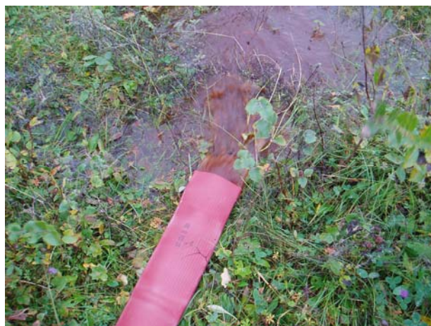
Bilde 2: Utspyling av vannledning med plugg
