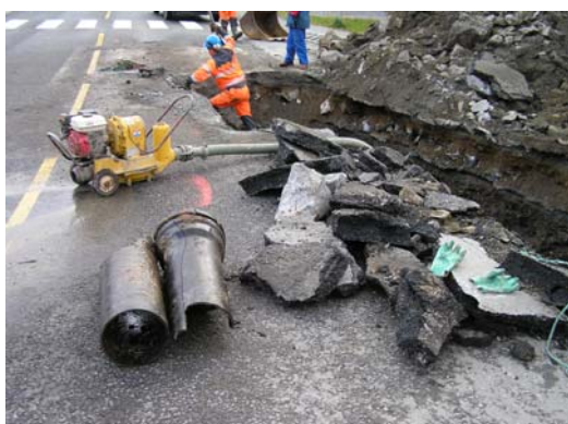
Bilde 4: Kommunal utbedring av ledningsbrudd
