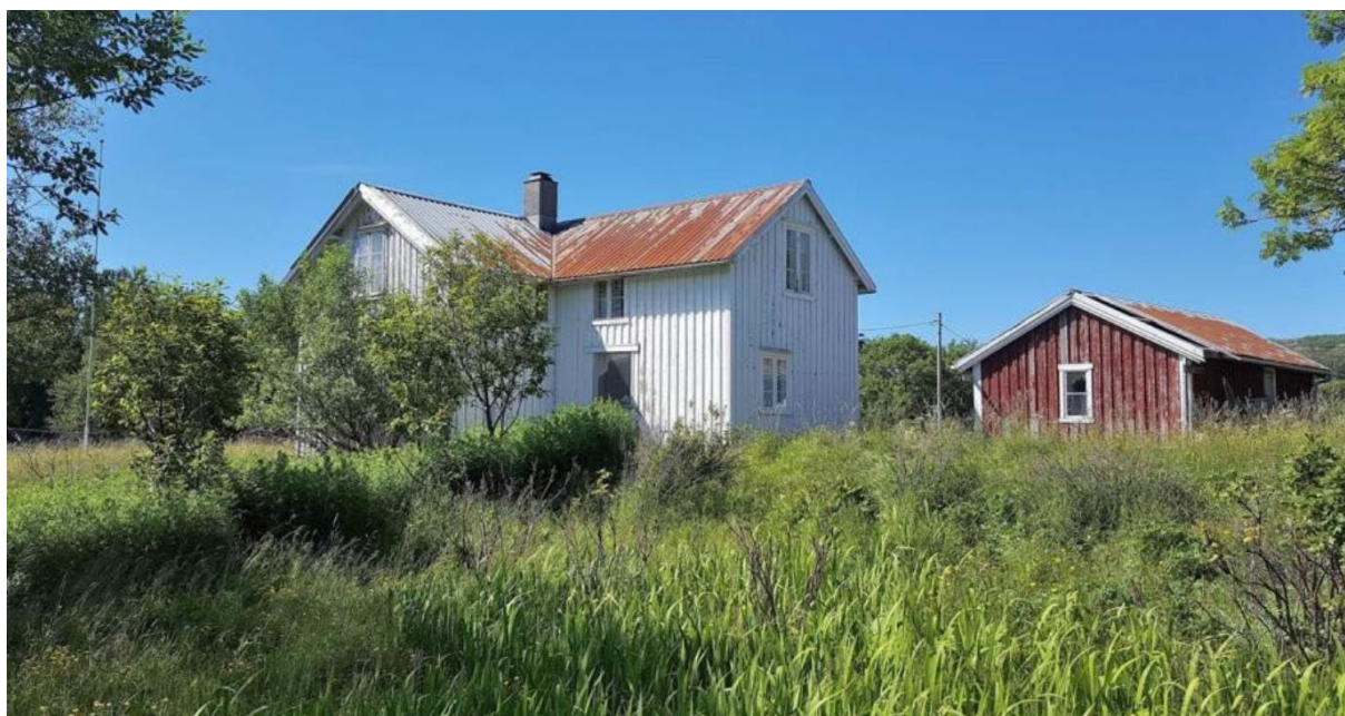
Foto 2. Dagens situasjon av planområdet.
