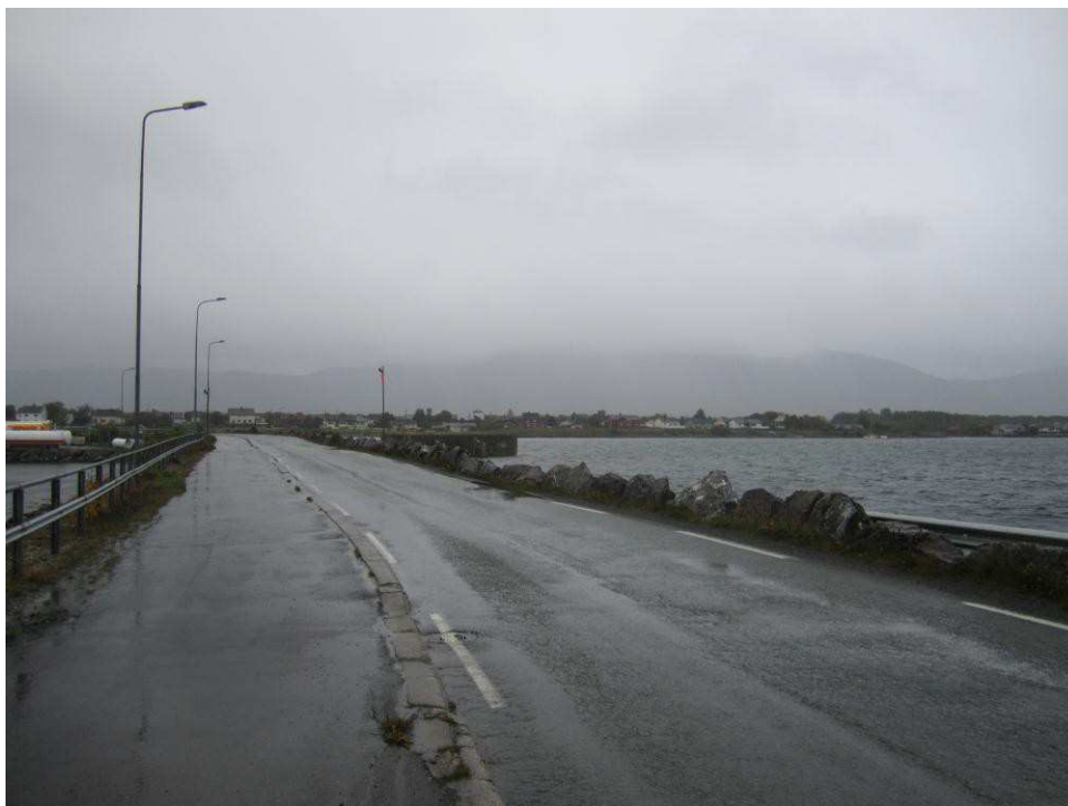
Behov for breddeutvidelse av molofylling for å tilrettelegge for syklende
