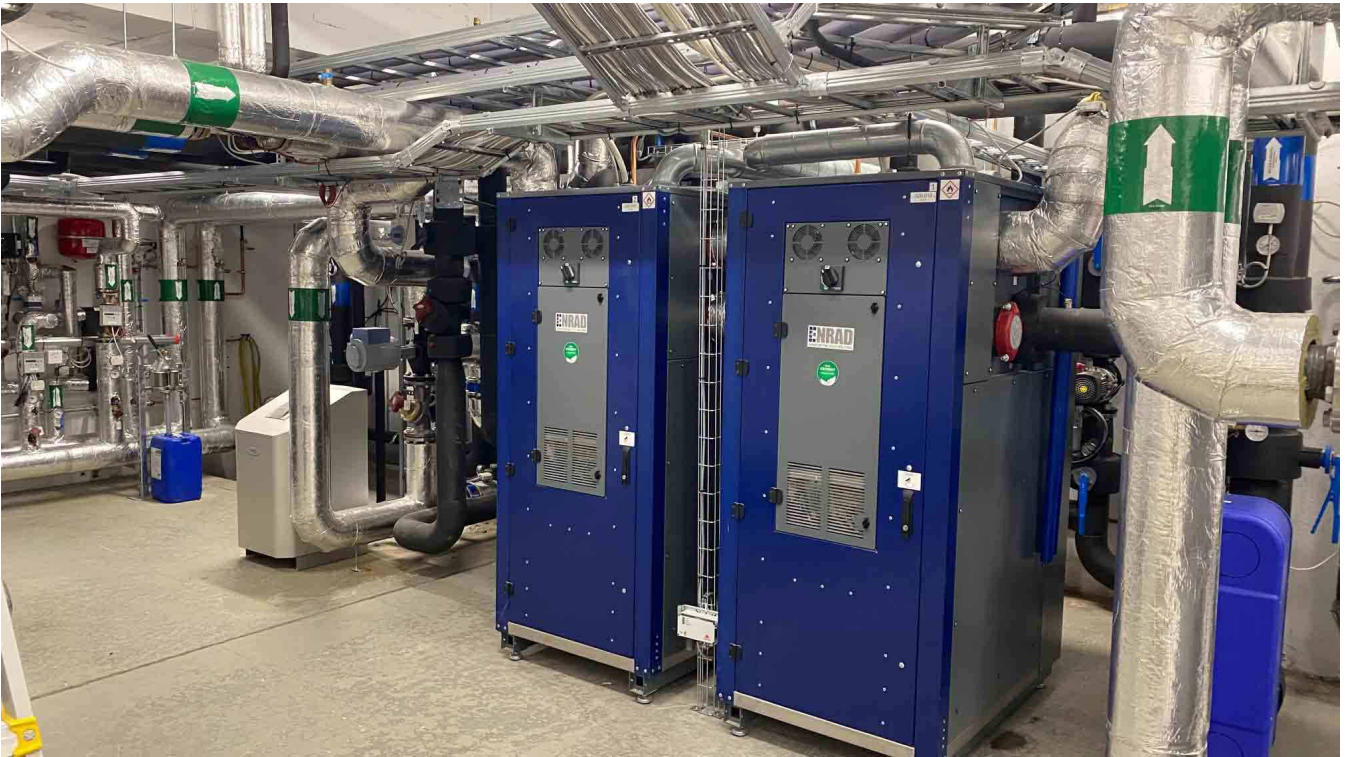
På Distriktsmedisinsk senter i Brønnøysund har Brønnøy kommune installert to 40 kW propanvarmepumper. Foto: Brønnøy kommune
